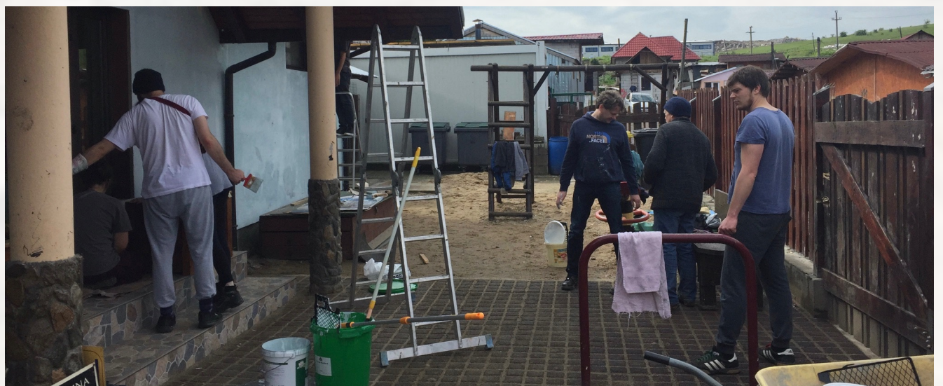
Eine Gruppe aus Fulda streicht die Fassade des Kindergartens in Pata Rat.
